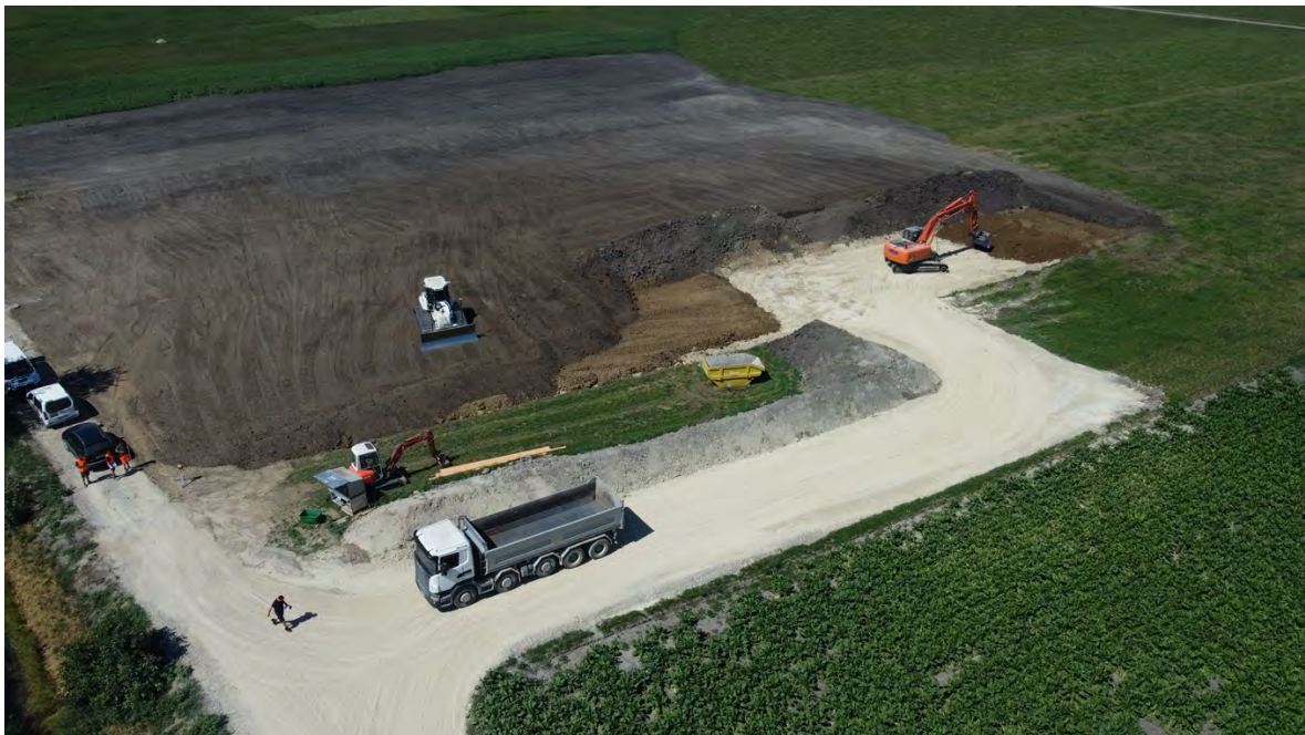
Abb. 5: A-Boden abtragen, seitlich anlegen, C- und B-Boden mit Bagger einbauen und A-Boden wieder mit GPS-gesteuertem Planierschild vom Bulldozer verteilen (Aufnahmedatum 04.10.2022).
