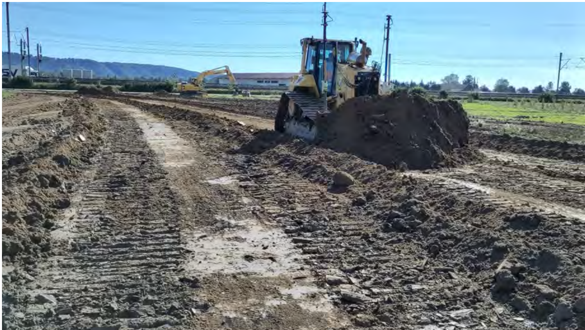
Abb. 4: Bulldozer mit GPS-gesteuertem Planierschild (Aufnahmedatum: 12.09.2022).
