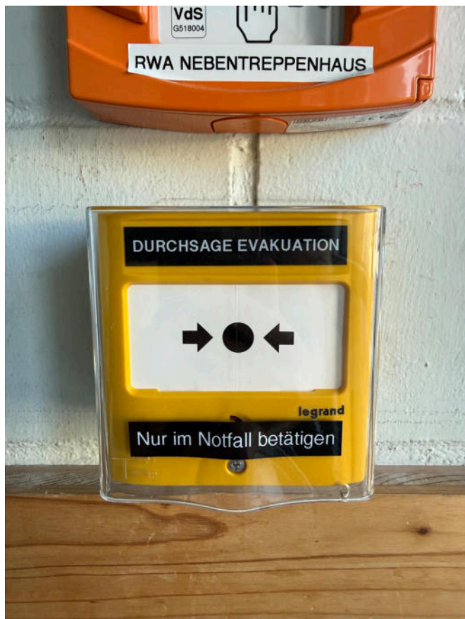
Bild: Alarmtaster "Durchsage Evakuation"
